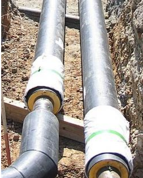
Figuur 37: Foto van warmtenet-buizen
